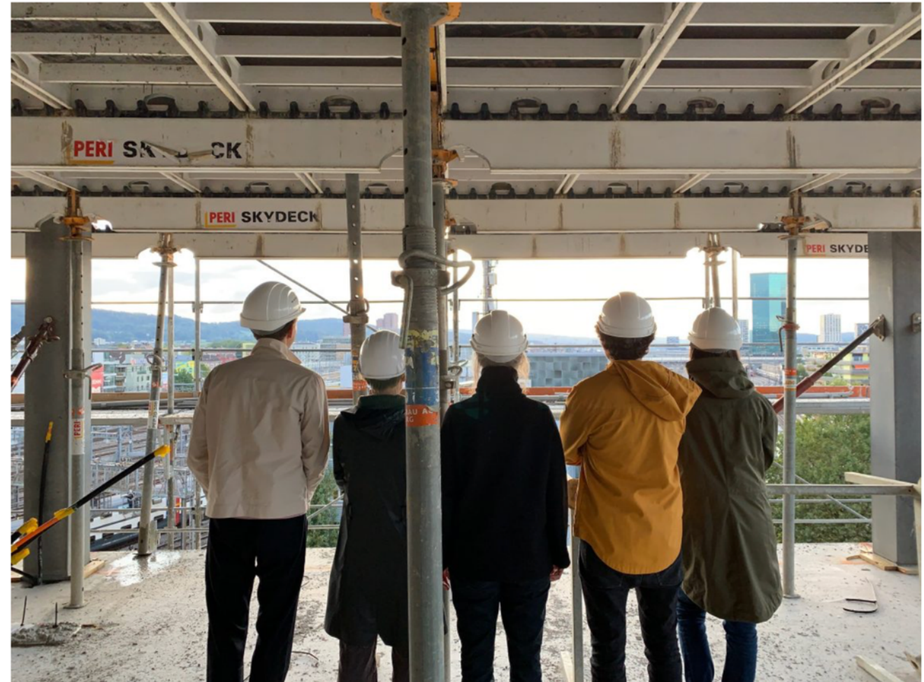
Bild: die Erko besichtigt die Zollhaus-Baustelle
